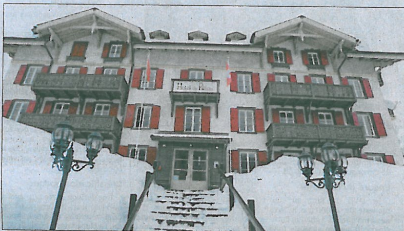
LAURÉAT L'Hôtel du Pillon est l'un des trois établissements de la station des Alpes vaudoises à avoir obtenu le nouveau label. LES DIABLERETS, LE 23 FÉVRIER 2009
